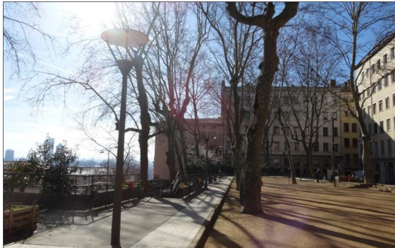
■ Pour éviter un effondrement de la place Colbert, des travaux seront entrepris par la Métropole de Lyon dès la fin mars. Photo Alain-Charles FABRE
